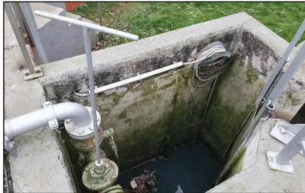
Abb. 41 Betonzustand Fettspeicher
