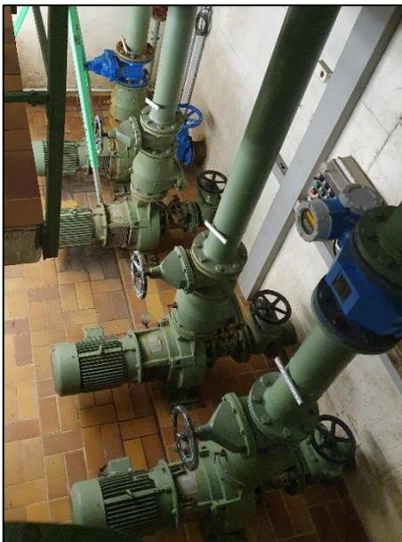
Abb. 14 Abwasserpumpen (links Trockenwetter-, rechts Regenwetterpumpen)
