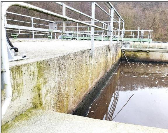
**Abb. 26** Zugabe Fällmittel Phosphat hinter Belüftungswalze 1
