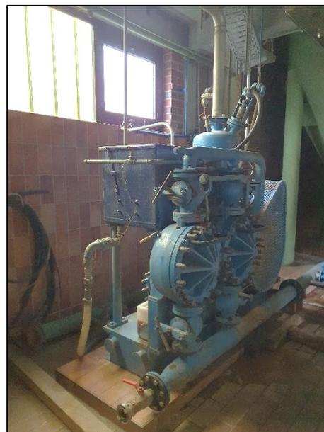
Abb. 32 Schlammpumpe
