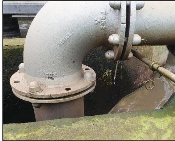
**Abb. 20 Zugabe Aluminiumhydroxidchlorid**
