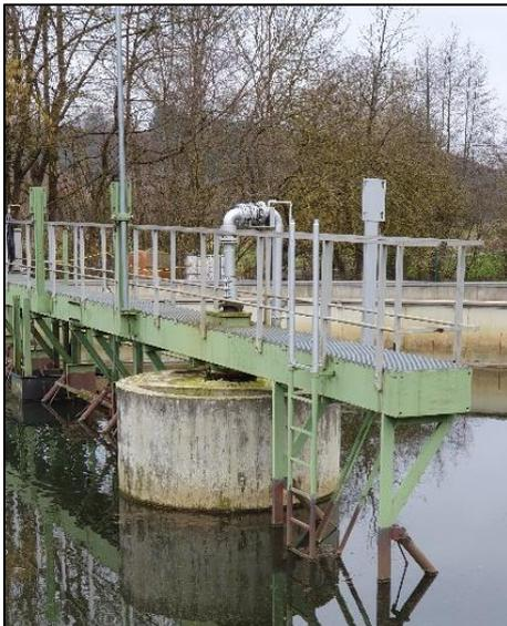
**Abb. 44** Räumer Nachklärbecken - Betonzustand
