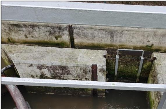
Abb. 40 Betonzustand Sandfang
