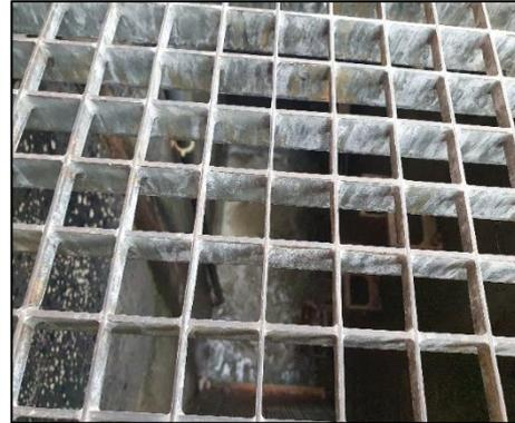
Abb. 13 Vereinigter Abwasserstrom und Grobrechen
