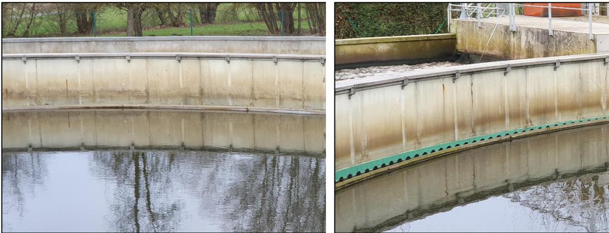
**Abb. 43** Beschädigungen Nachklärbecken
