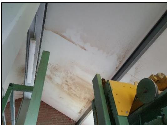
Abb. 47 Schlammwässerung - Verschmutzte Decke
