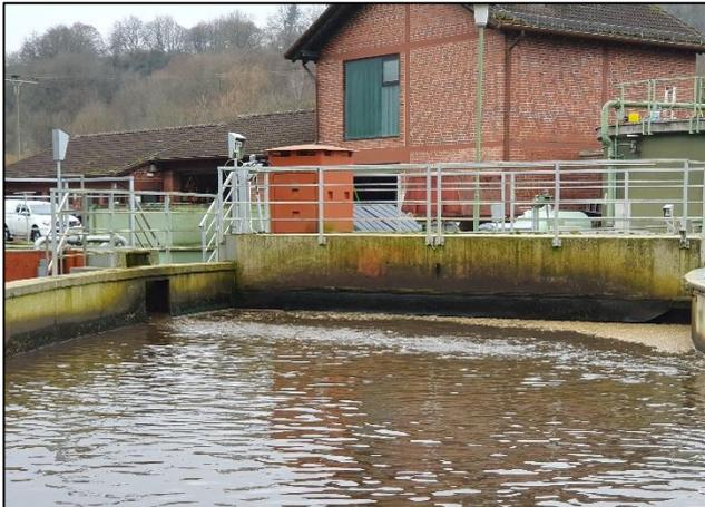
**Abb. 24** Zulauf Belebungsbecken mit Belüftungswalze 2
