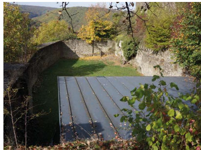
5 Abb. 6: Lagerplatz (Vorburg, Bereich ehemalige Kornkammer)
