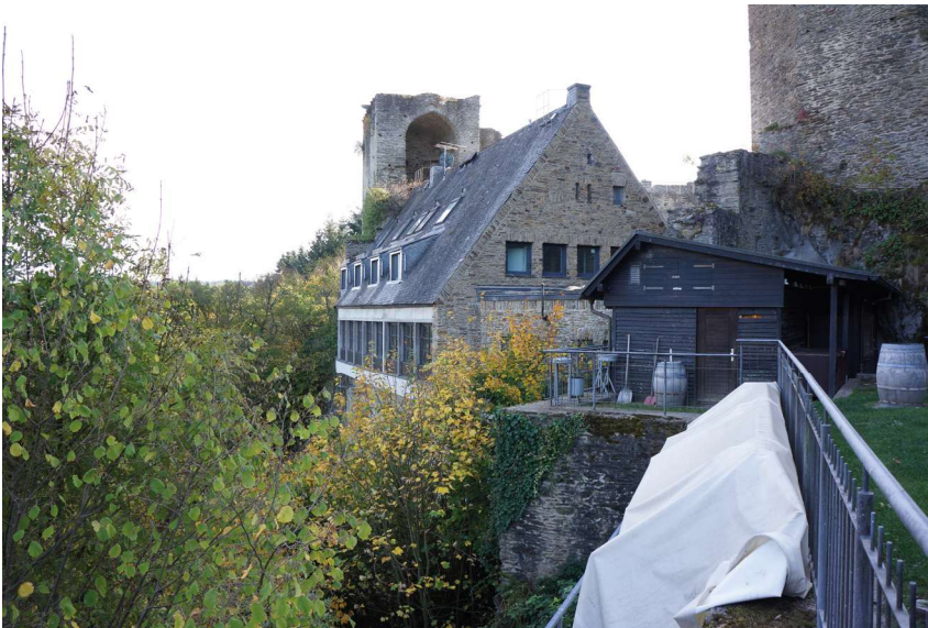
Abb. 41: historisiertes Wirtschaftsgebäude: Foto Bestandsgebäude
