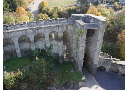
15 Abb. 16: untere Terrasse (ehemalige Freifläche Vorburg)
