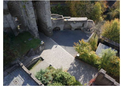
3 Abb. 4: Eingangsbereich (Vorburg)
